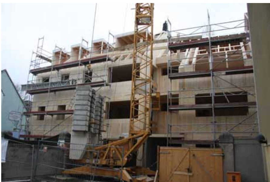
Die Wände und die Decken sind auch hier in Massivholzbauweise ausgeführt.
