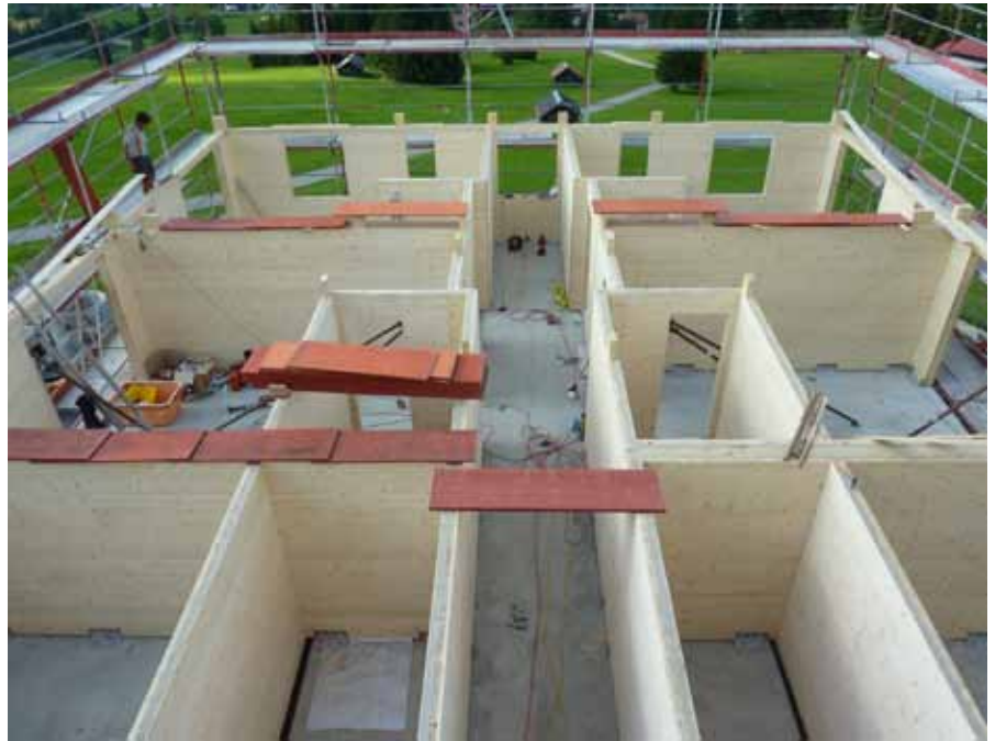
Die Massivholzwände sind je nach Anforederung in Dicken von 17 bis 40 cm ausgeführt.
